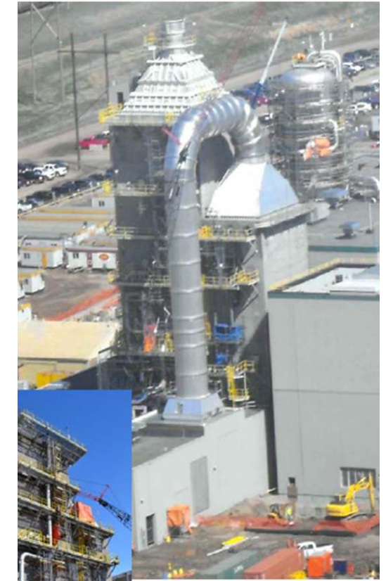
Captage de CO 2 sur une centrale de production d'électricité au Canada (3300 tonne /jour)
