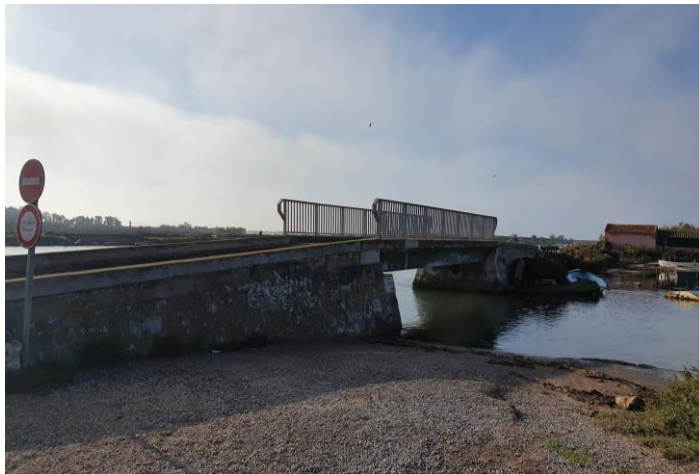
Passerelle du Pillou @ Montpellier
